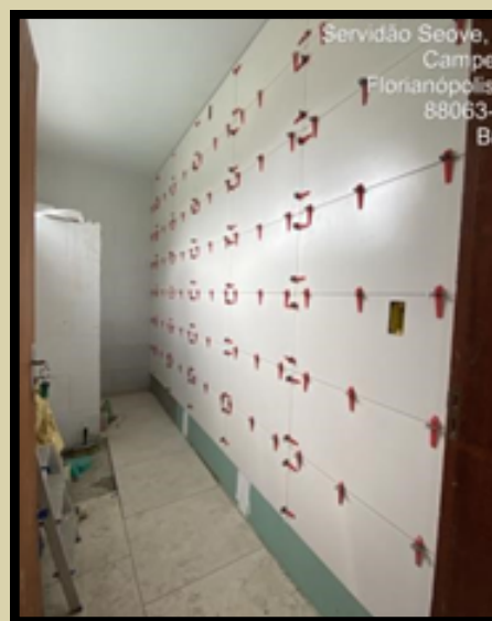
AVANÇO COLOCAÇÃO DOS AZULEJOS
