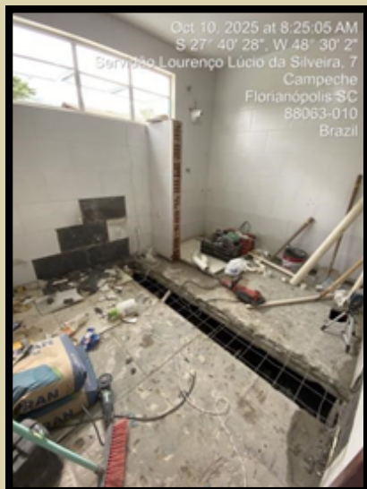
ABERTURA DO PISO/LAJE PARA ADEQUAÇÃO DA TUBULAÇÃO DE ESGOTO
