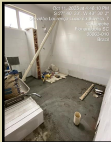
EXECUÇÃO DO CONTRAPISO DO NOVO BANHEIRO
